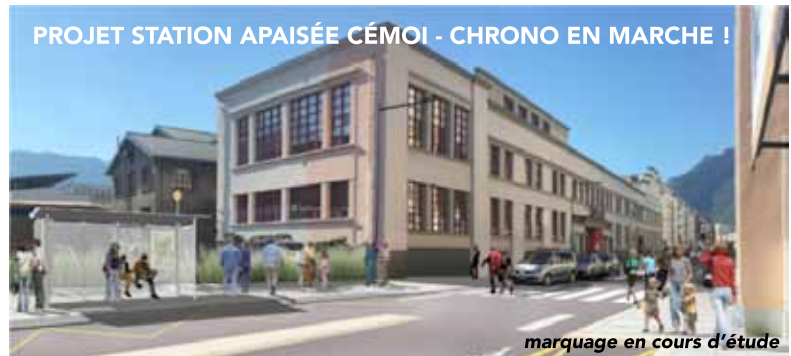
marquage en cours d'étude
